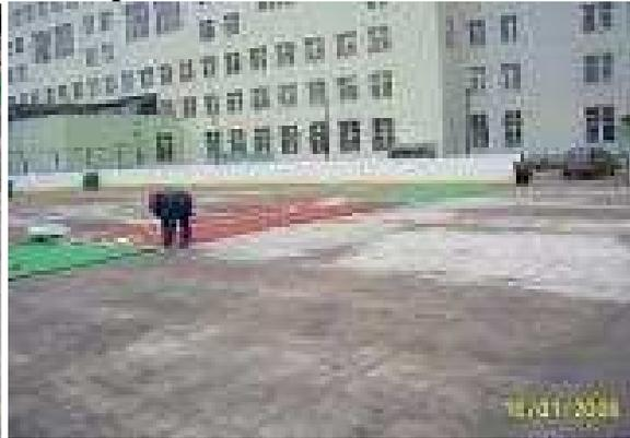
10. Прямолинейность стыка 1-ой и 2-ой полос обязательно проверяется сильно натянутым от одного края до другого края полос капроновым шнуром. При необходимости стык надо выровнять точно по шнуру.
