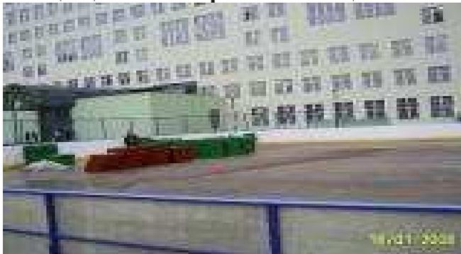
8. Следуя дизайн-проекту строго по разметке укладывается первая полоса покрытия, собранная из квадратов 1x1 м.
